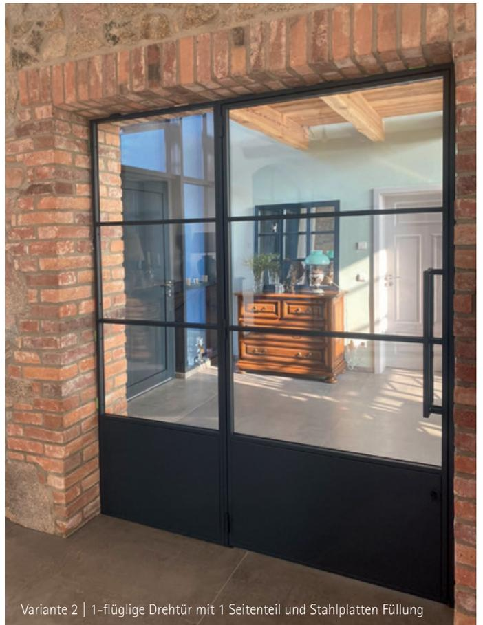
Variante 2 | 1-flügelige Drehtür mit 1 Seitenteil und Stahlplatten Füllung
